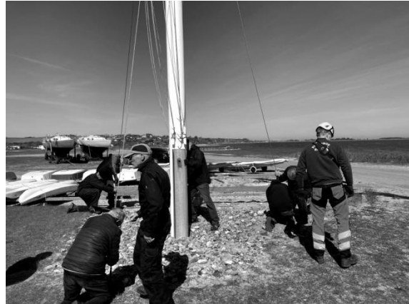
Den reoverede signalmast sættes på plads 28. april 2022
