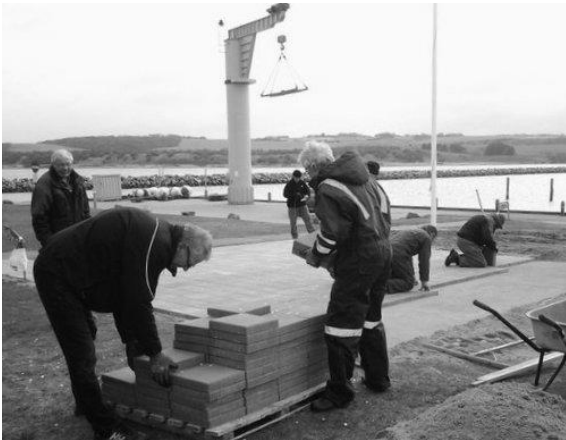
Der etableres fliseplads med borde 2017
